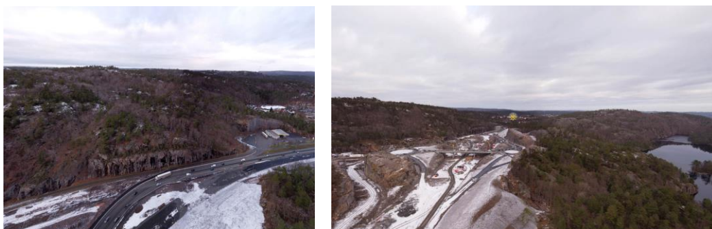
Figur 2-11: og Figur 2-12: Grauthellerkrysset er en del av Nye Veier sitt prosjekt E39 Kristiansand-Mandal som Ytre ringvei kobles på når det kommer ut av tunnelen. Utsnitt hentet fra Afs Virtual tour generert by Pantour 07.02.2022 og viser landskapet som tunnelen kommer ut av.
