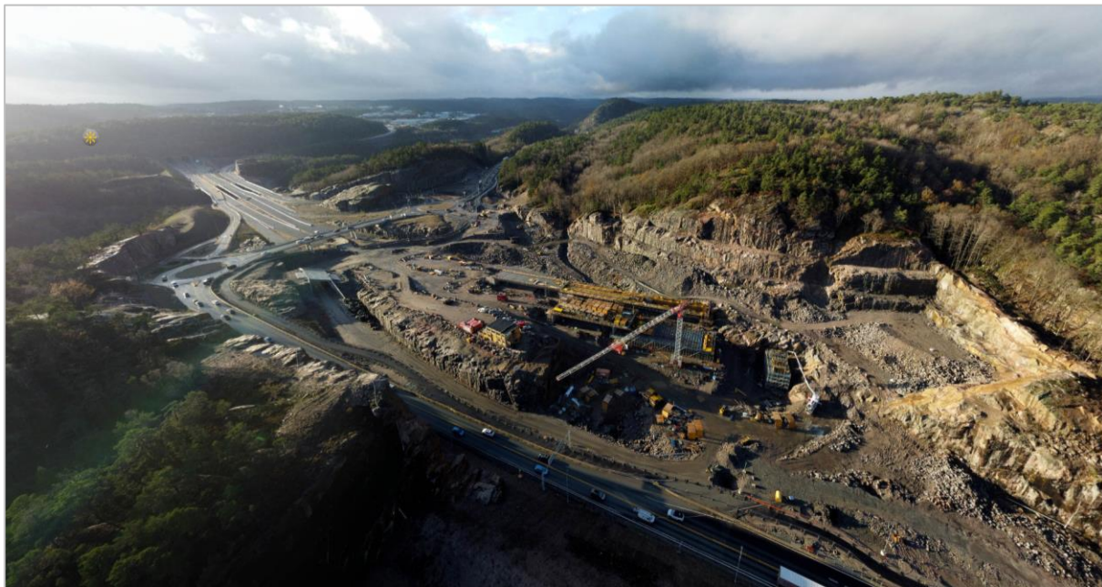
Figur 2-4: Oversiktsbilde av utbyggingen ved Grauthelleren pr oktober 2022. Kilde: pano.afgruppen.no.
