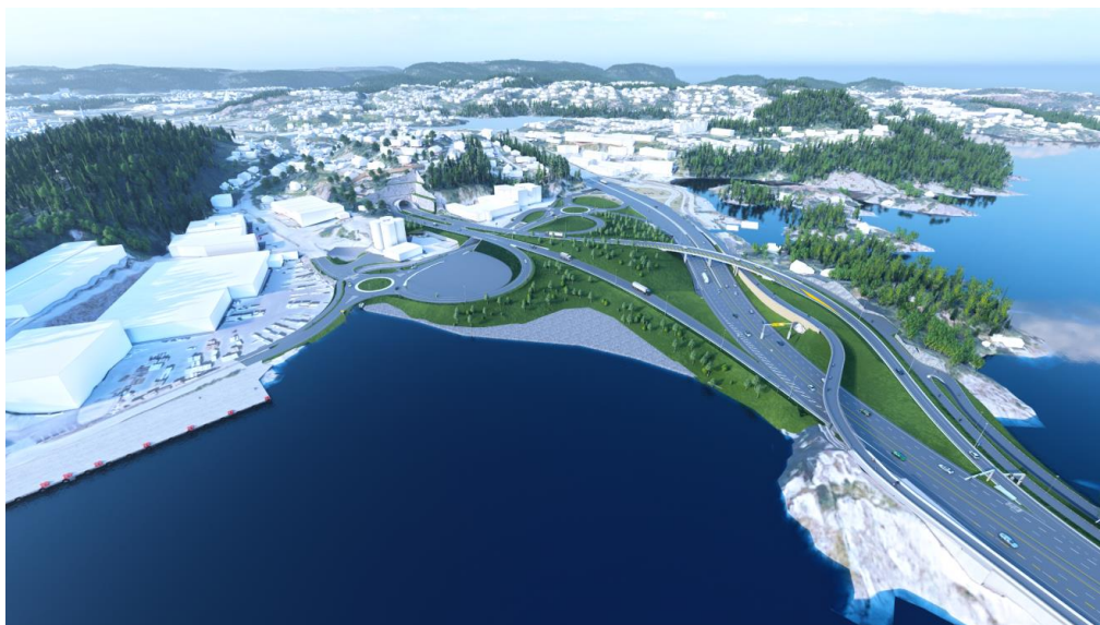
Figur 6-7: Det nye krysset i Vige, Vigekrysset, kobler seg til eksisterende E18 like vest for Varoddbrua.
