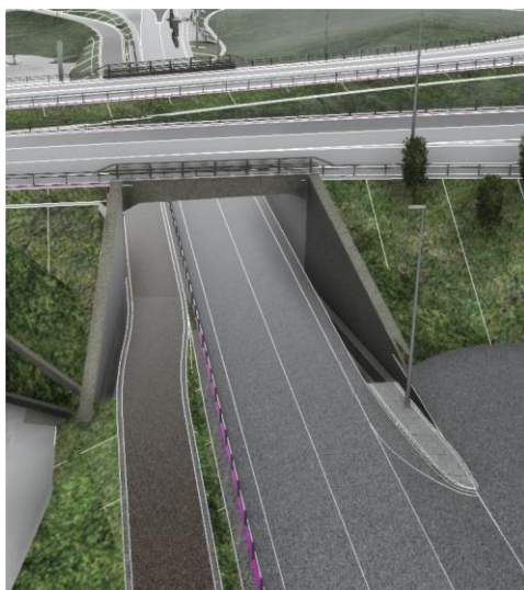
Figur 6-16: Kulvert i Vige, under Ytre ringvei.
