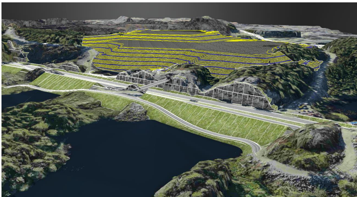
Figur 4-35: Fyllingen på Øygardsvatnet sett fra vest. Ny E39 i forgrunnen. (Del av Alternativ A)
