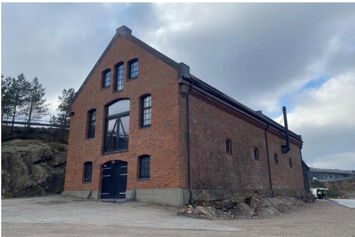
Figur 7-5: Krutthuset sett fra vest.
