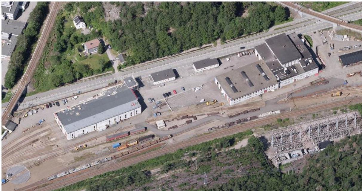
Figur 7-18: Lokstall og lokstall med verksted på Krossen.
