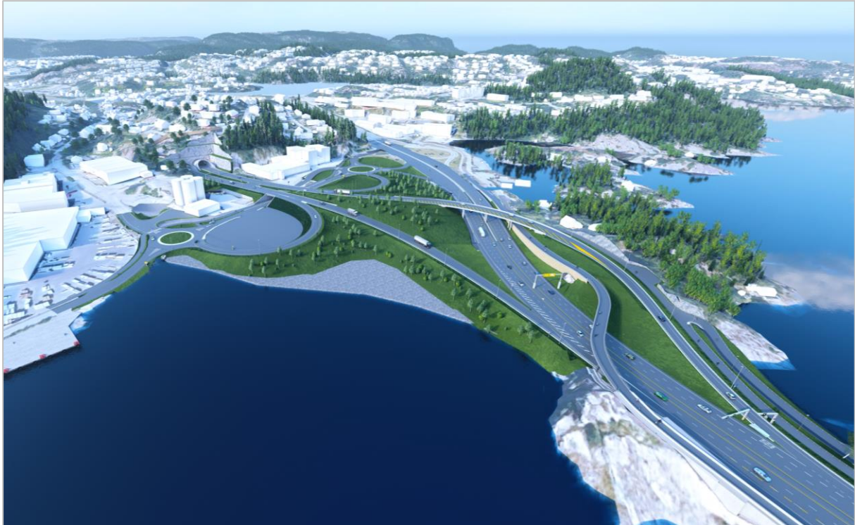
Figur 4-2: Det nye krysset i Vige, Vigekrysset, kobler seg til eksisterende E18 like vest for Varoddbrua.
