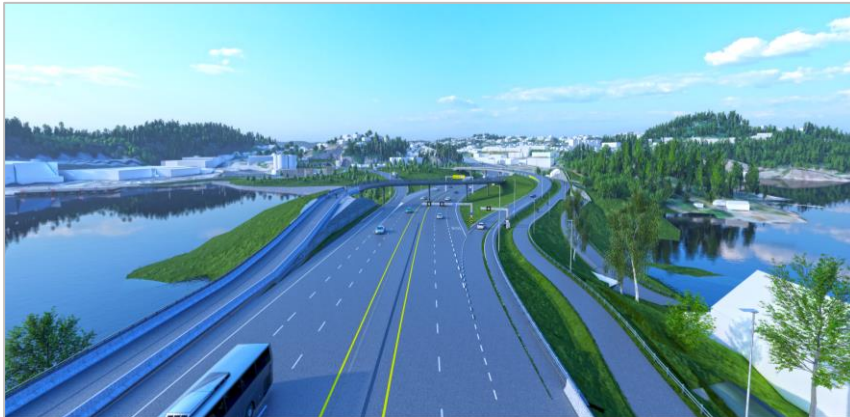
Figur 4-22: Akselerasjonsfelt og retardasjonsfelt der Ytre ringvei kobler seg til eksisterende E18 i Vige.
