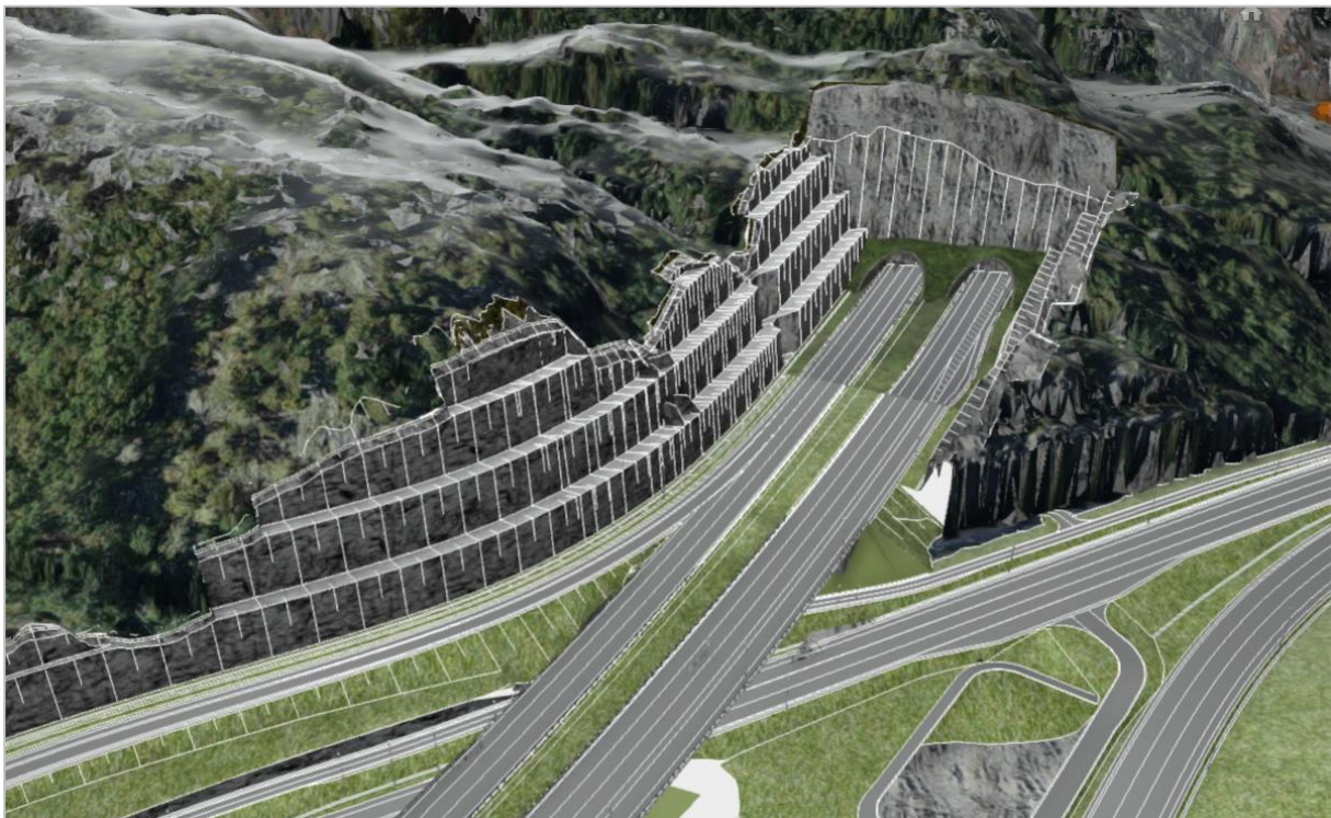
Figur 4-60: Forskjæringen og fartsendingsfeltene ved Grauthelleren.
