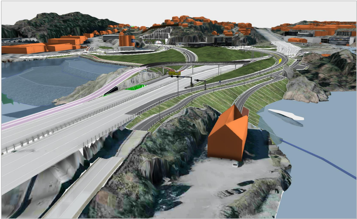
Figur 4-55: Avkjøringsrampe over E18 og lokalvei til Varodden.
